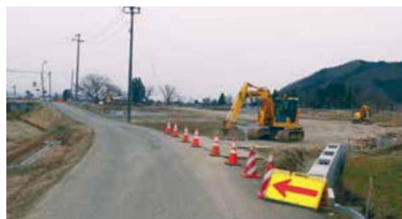
■建設工事中の大瀬蔵野橋
