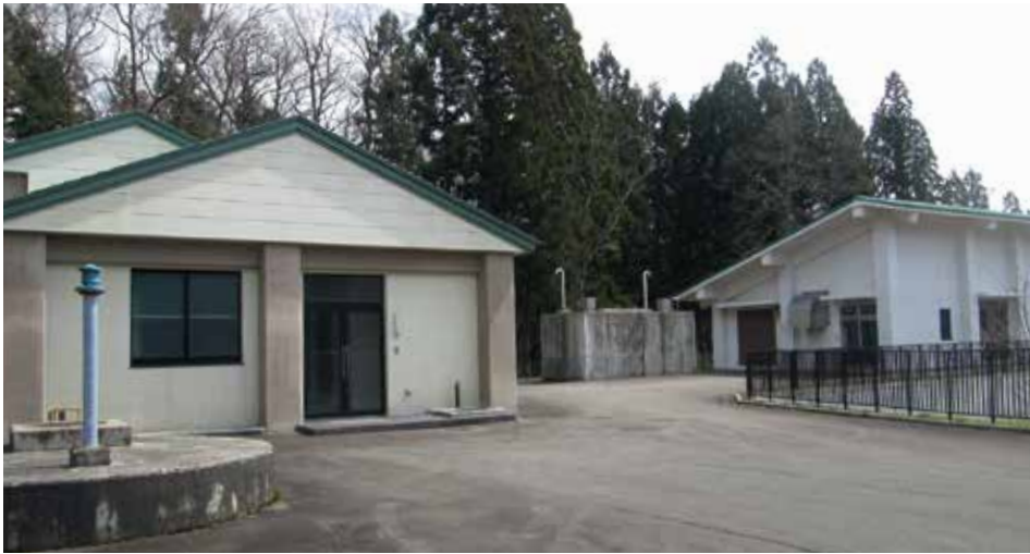
■国道46号線を横断して更なる拡大を担う西明寺低区浄水場
