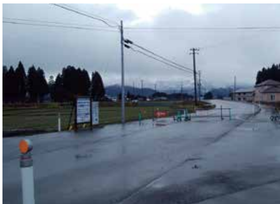
■改良工事が進まない神代中央線
