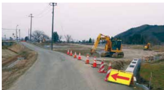
■建設工事中の大瀬蔵野橋
