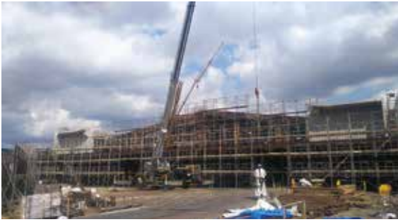
■財政改革も期待される建設中の新角館庁舎
