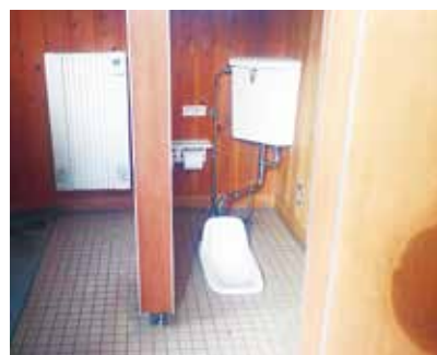
洋式化される西宮家の公衆トイレ
