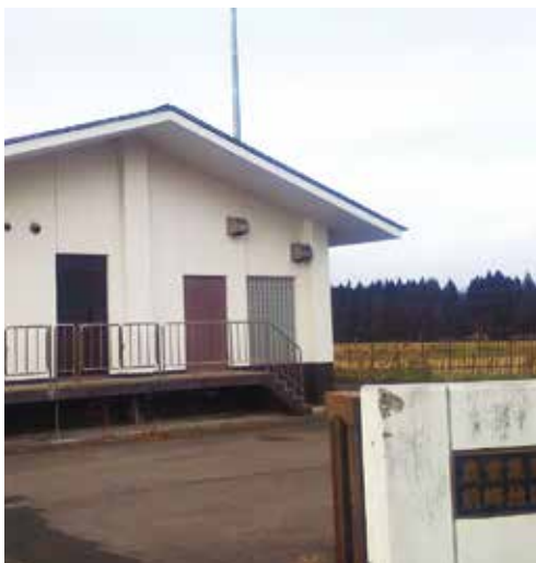
■値上げされるか？上・下水道料金（白岩地区の集落排水施設）
