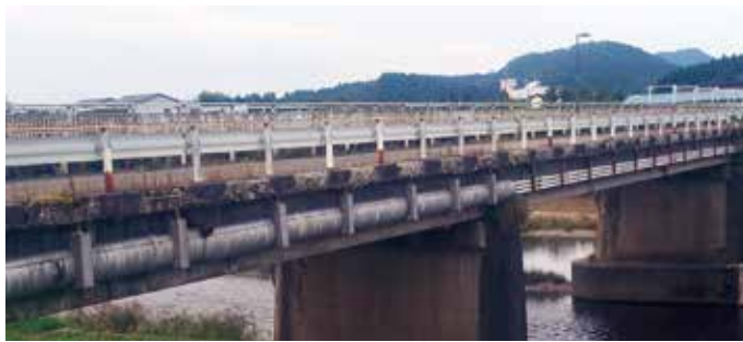
■目視では損傷が目立つ内川橋
