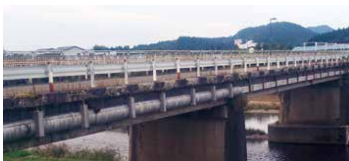
■目視では損傷が目立つ内川橋
