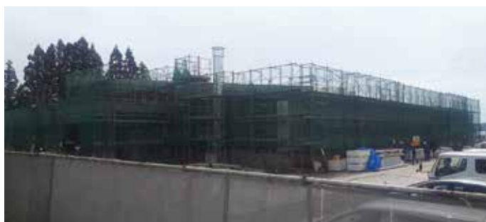
■建設中の総合給食センター（学校給食の無償化はいかに）
