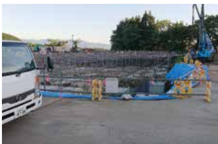
■工事が進む新角館庁舎
