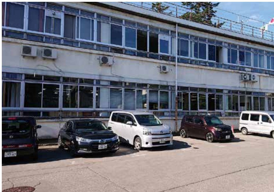
■老朽化した角館庁舎
