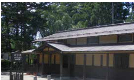
■改修されるポケットパークトイレ(伝承館前)
