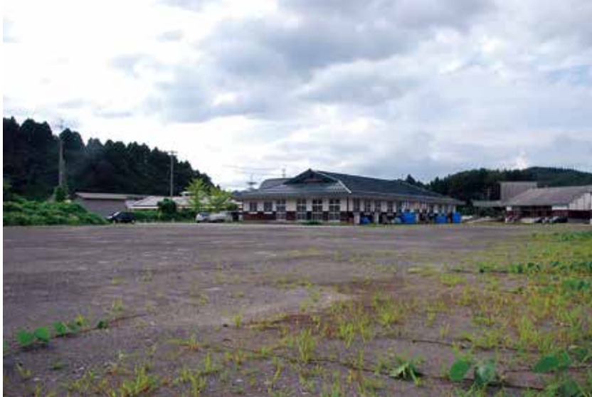
■新角館庁舎建設予定地
