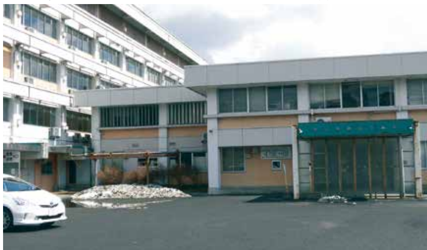
■解体を待つ旧市立角館病院
