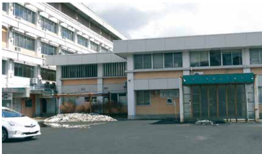
■解体を待つ旧市立角館病院
