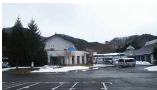
■老朽化による施設整備事業費が膨らむ花葉館
