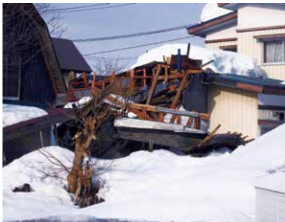
■緊急対応が必要な危険空き家
