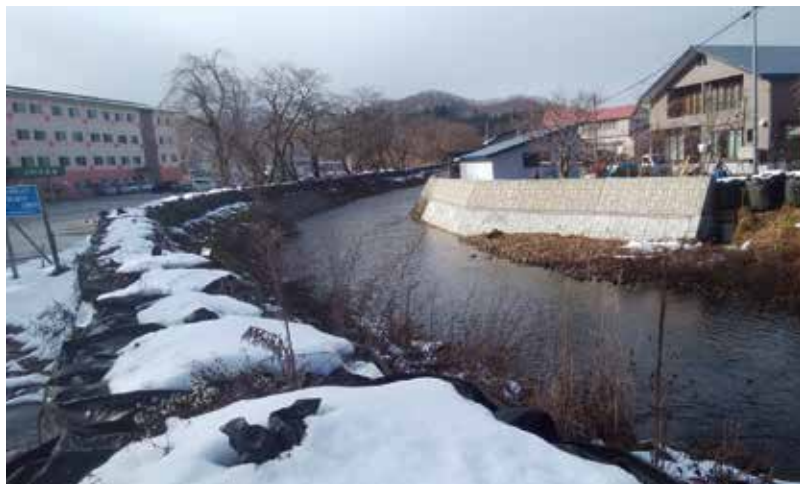
■改修工事の早期完成が待たれる入見内川と川下田川
