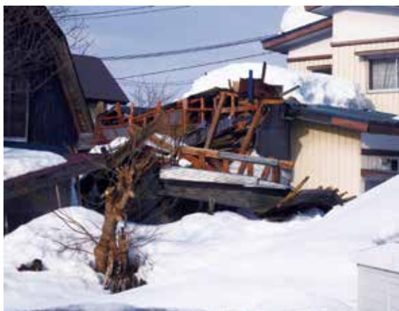
緊急対応が必要な危険空き家
