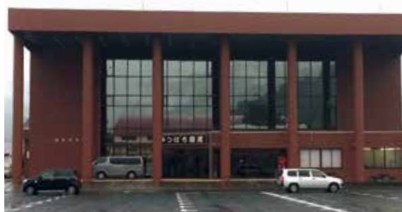
■設備の更新が待たれる市民会館
