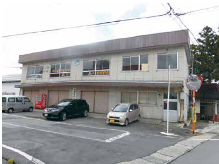
■マロンクラブが移転設置される 旧JA大豆センター(西木町六本杉)
