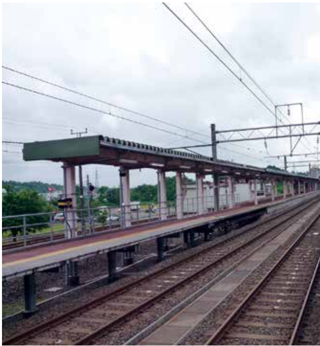
■設置が待たれる角館駅の東西自由通路事業
