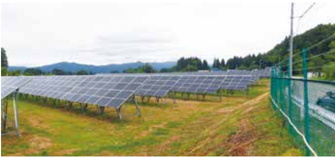
■稼働中の太陽光発電施設
