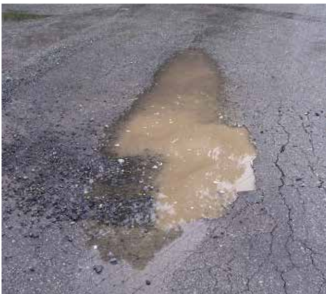
■迅速な修繕が待たれる道路破損箇所
