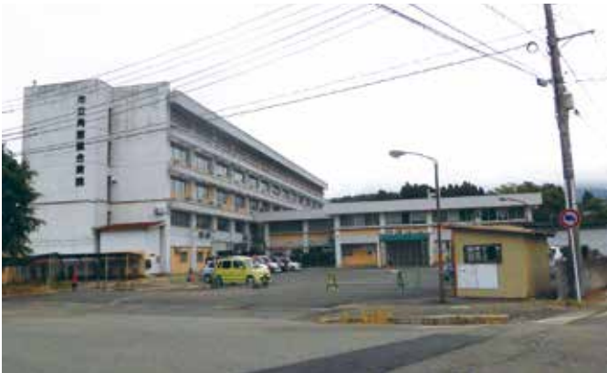
■解体が予定されている旧角館総合病院
