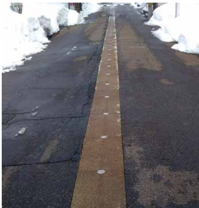
■大仙市の消雪設備
