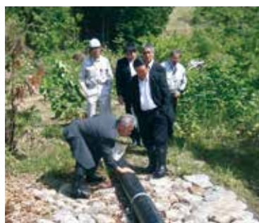
■温泉引湯管布設状況
