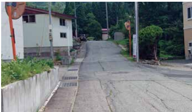
■側溝が必要な生保内斎場へ向かう道路
