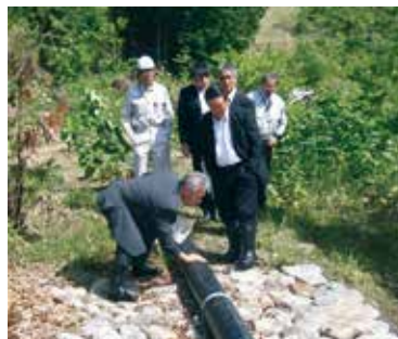
■温泉引湯管布設状況
