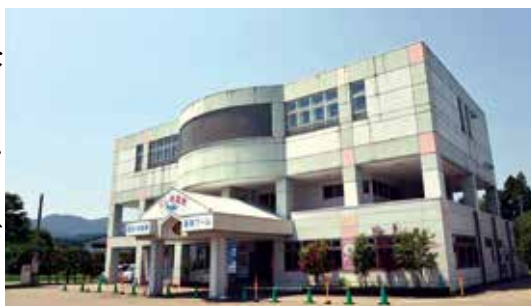
■屋上防水シートの劣化により雨水が漏水するクリオン
