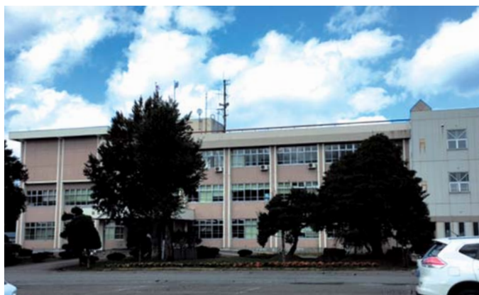
■仙北市の顔 田沢湖庁舎、早急な耐震工事が必要
