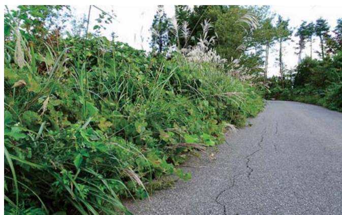
■法面から市道に張り出した草
