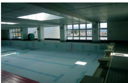
■改修されるクリオンプール
