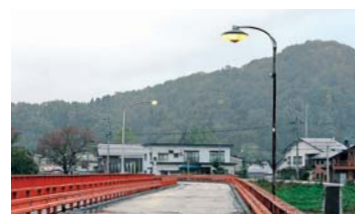
■整備される角館横町橋街灯
