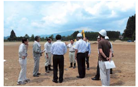
■終了近い企業誘致造成敷地
