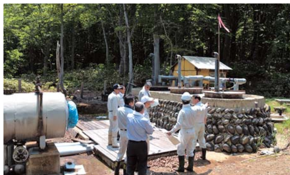
■カラ吹き2号源泉の造成塔・集湯槽の視察
