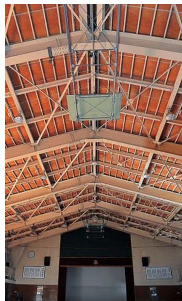
■天井落下防止対策が実施される体育館
