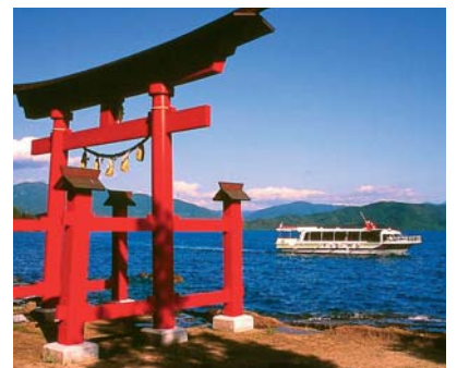
■崩落が進む御座ノ石鳥居の石量
