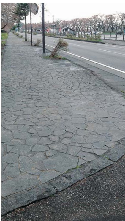
■歩道の段差を無くすなどの安全対策を
