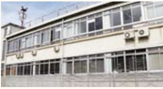
壁面が落下した庁舎
