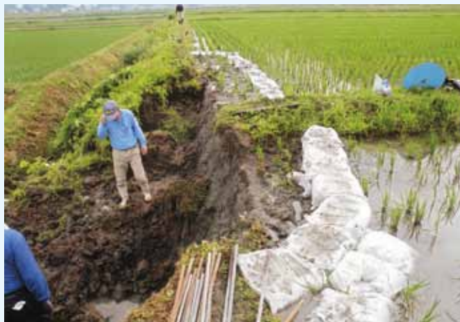
6月21日の地震で崩落した田んぼの畦畔(角館町白岩)
