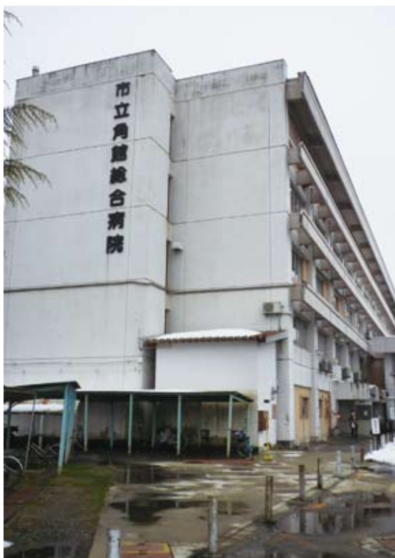
早期改築が検討されている市立角館総合病院
