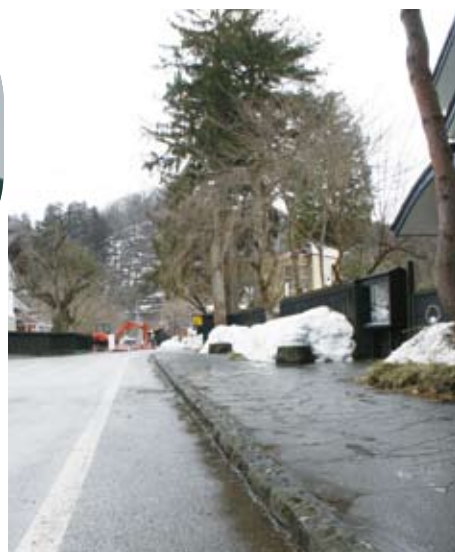
安全安心道路維持の整備費で整備される予定の歩道の段差
