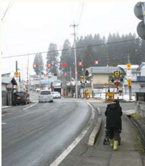
危険性が潜んでいる狭隘な歩道の県道広久内線
