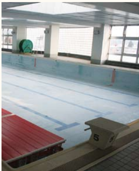
部内検討を続けているクリオンスプールの改修
