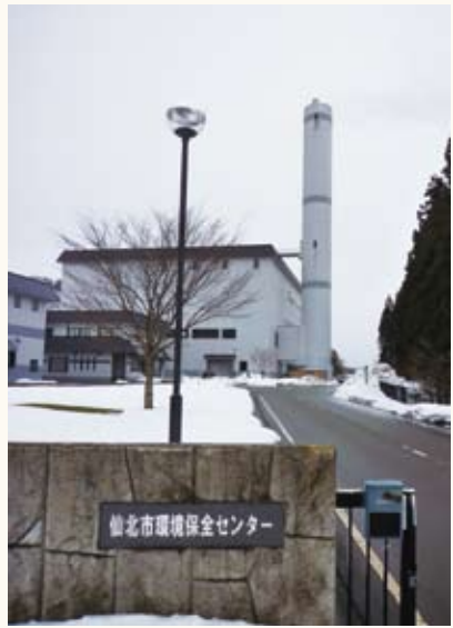
民間で運営している 環境保全センター
