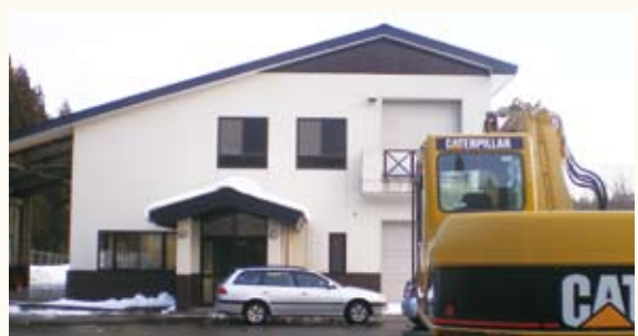
ゴミの減少傾向が続く西木地区の最終処分場
