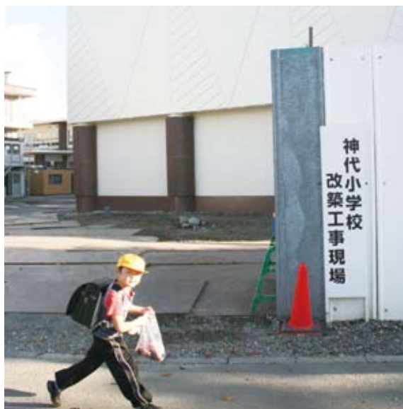
間もなく竣工の神代小学校
