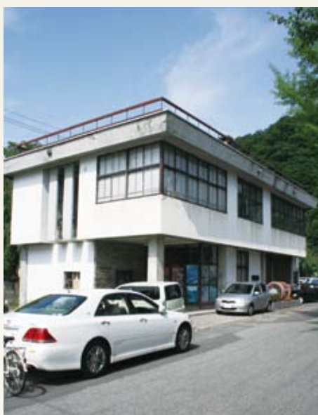
解体が決まった旧角館図書館
