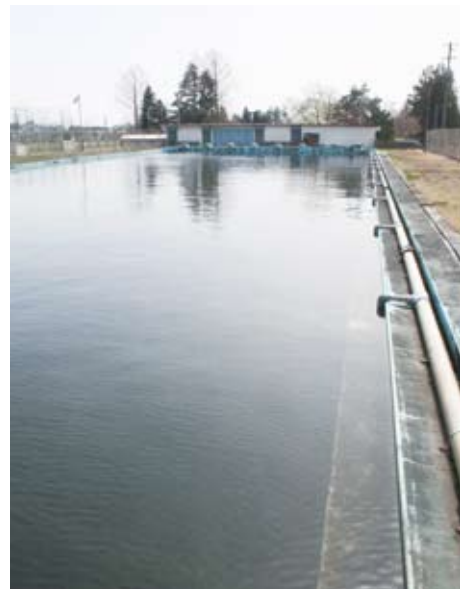
使用不能の角中プール
