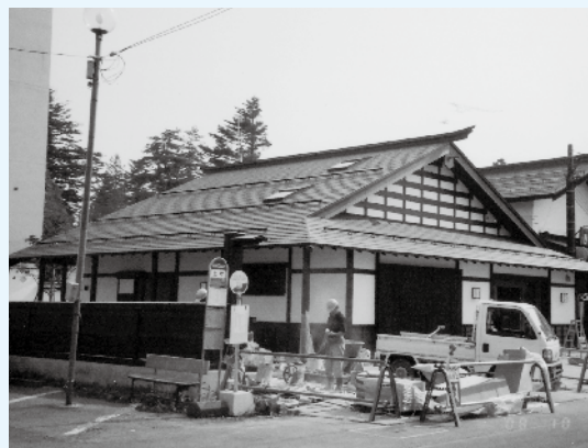
工事中の田町交流広場
