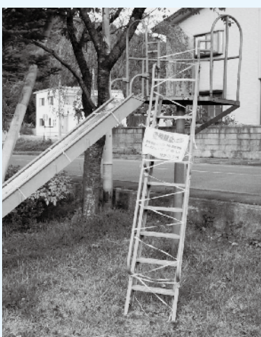
使用禁止の遊具、修繕か？撤去か？
