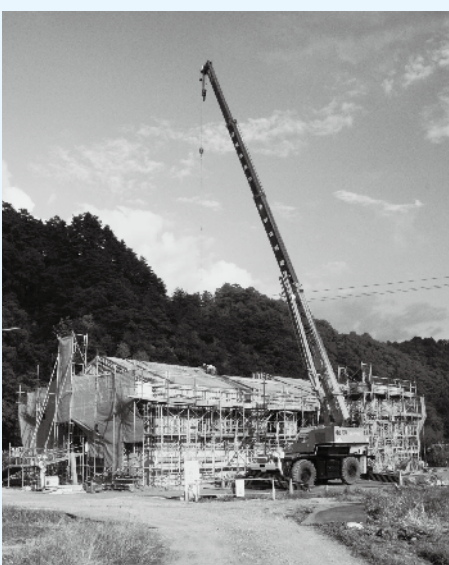
順調に進む農業集落排水事業 田沢処理場
