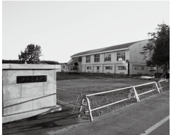
起工式を終え改築着工の神代小学校
