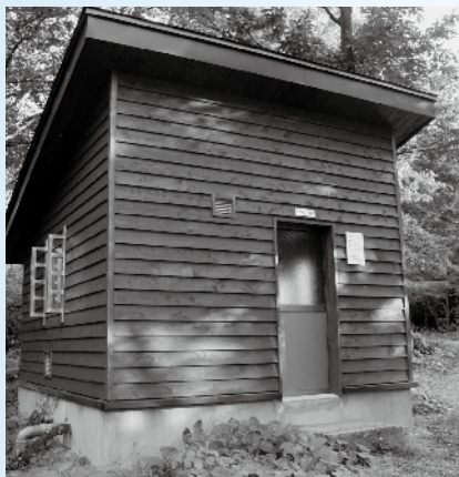
水沢温泉地区に供給する分湯槽
