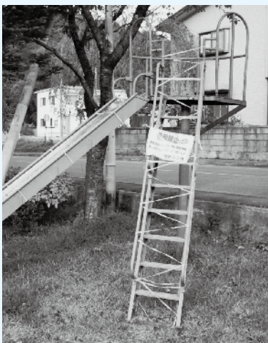
使用禁止の遊具、修繕か？撤去か？
