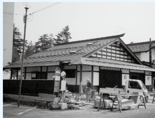
工事中の田町交流広場
