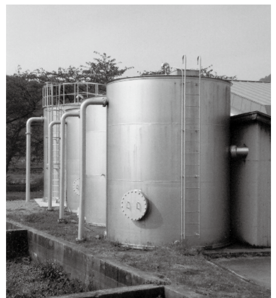
市民の安全な水にかかせない急速ろ過器
