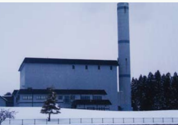
修繕費の削減が求められるゴミ処理場
