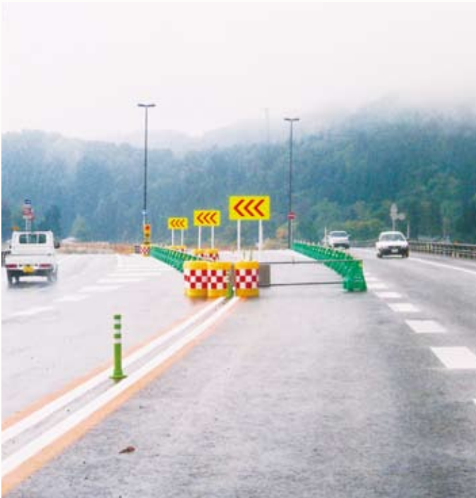
角館バイパスの延伸はいつ!?
