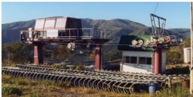
修理される水沢ロマンスリフト
