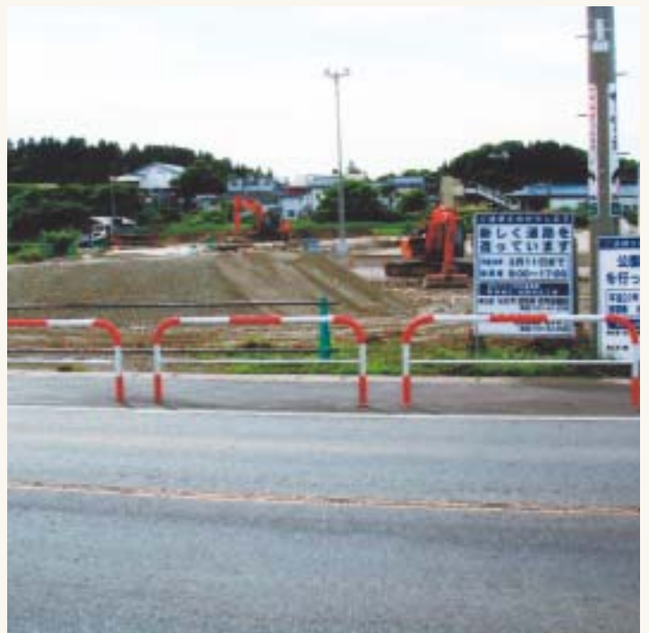
工事が進む角館駅東地区
