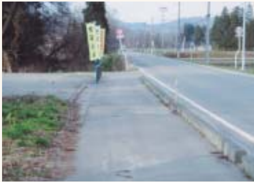
歩道工事が急がれる 広久内停車場
