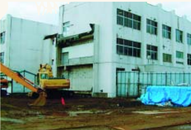
学校建設に支障のため解体された音楽室
