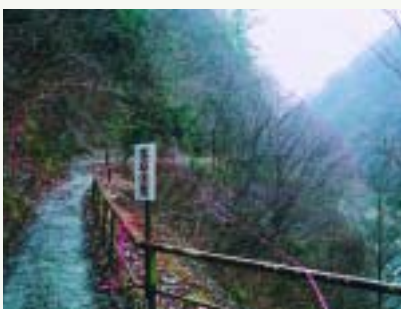
工事中の抱き返り遊歩道
