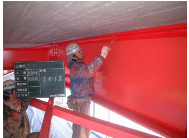
「塗り替え工上塗り作業状況」 【他自治体での事例】
