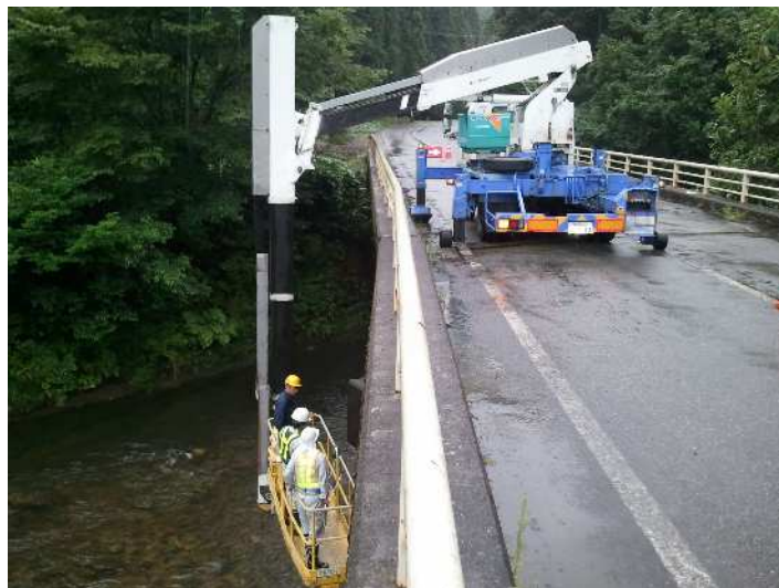
橋梁点検車を使用した【定期点検】実施の様子
