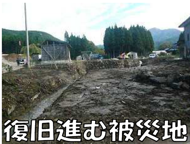
土砂崩れ箇所
