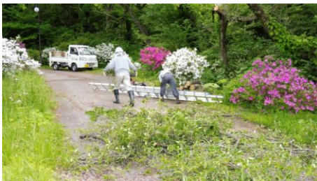
伐採した桜の木の撤去作業
