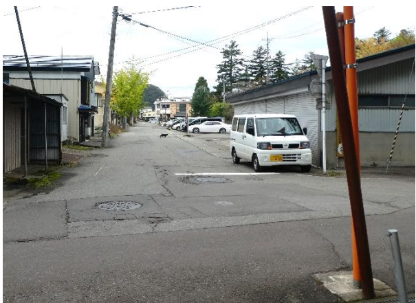
5 市道横町東線（東から）
