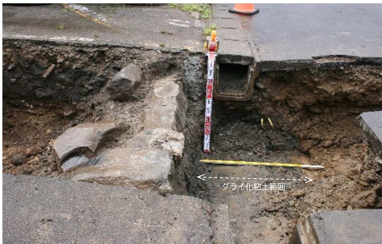
2 試掘坑G公用車駐車場付近 (東から)
