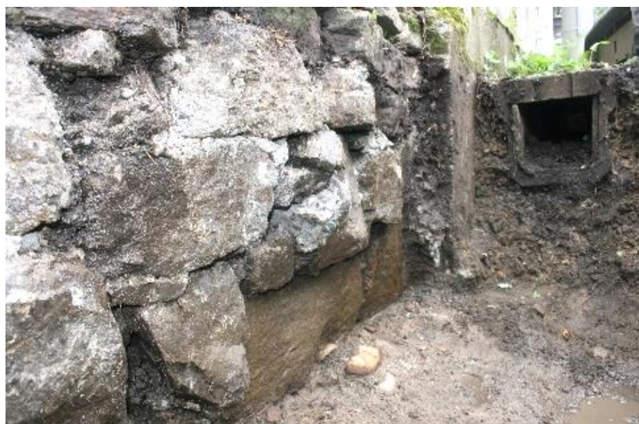
2 試掘坑Ⅰ南端水路大威徳 石石垣の検出状況 (北東から)
