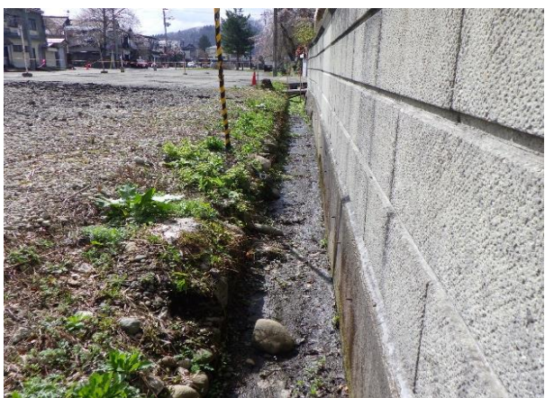
3 火除け地北端水路（東から）
