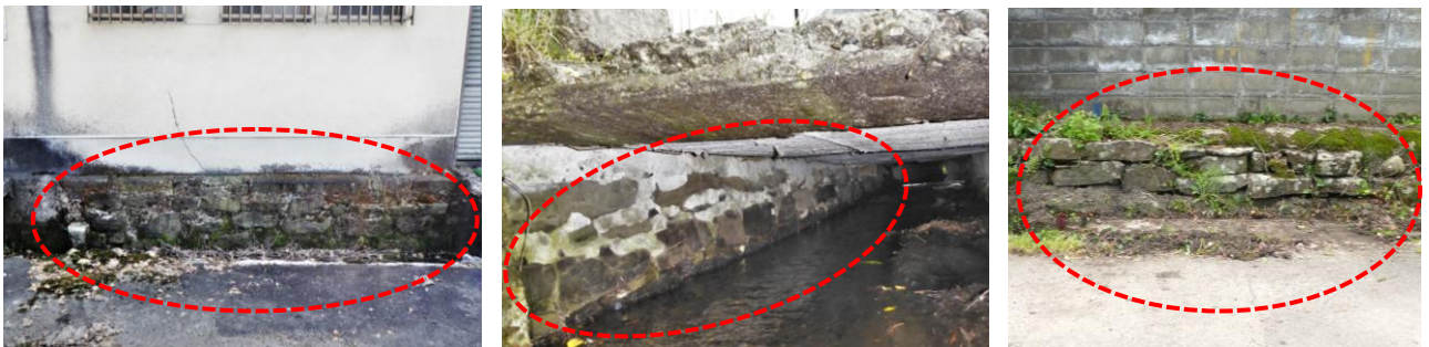
第 19 図 大威徳石を積んだ水路護岸用の石垣
