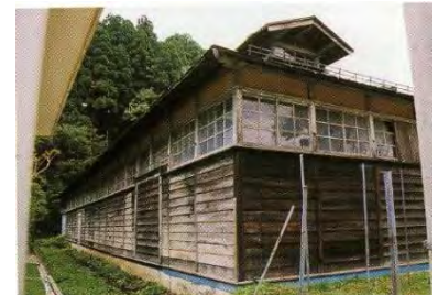
旧角館製糸工場
