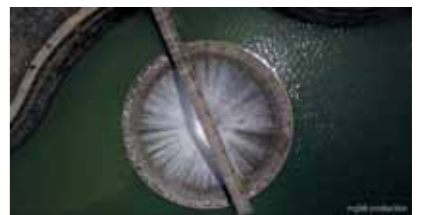
【特別賞】 『Shing Mun Bell-Mouth Spillway』 Ray Leung(中国)
