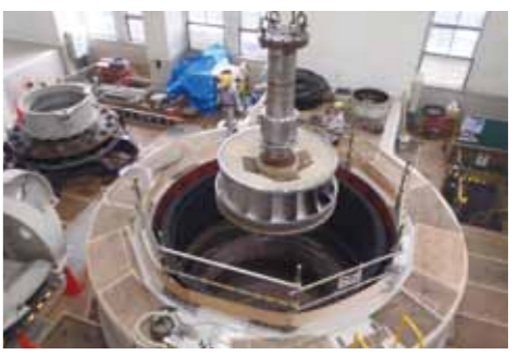
老朽化に伴い3台ある水車発電機の改修工事が進められています。
