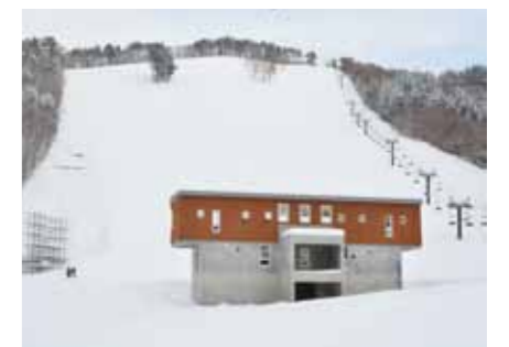
完成した審判棟。審判用スペースと放送設備があり、1階に機材倉庫、2階に会議室があります。
